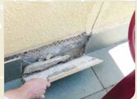
Fot. 1-4. Skutki błędów w wykonstrowaniu tzw. trudnych i krytycznych miejsc (fot. autor)
