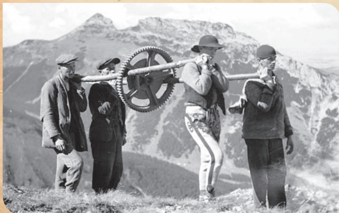
Transport części składowych roboczej kolejki linowej – koło zębate wyciągarki. W głębi widok na Giewont od strony południowej
